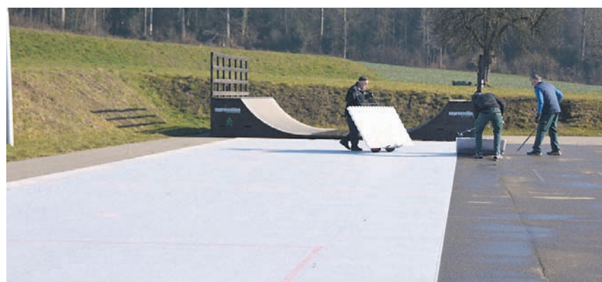
Letzte Woche wurde das Eisfeld auf der Burkertsmatt abgebaut und ins Lager gebracht. Dort bleiben die Kunststoffplatten vorerst auch.
